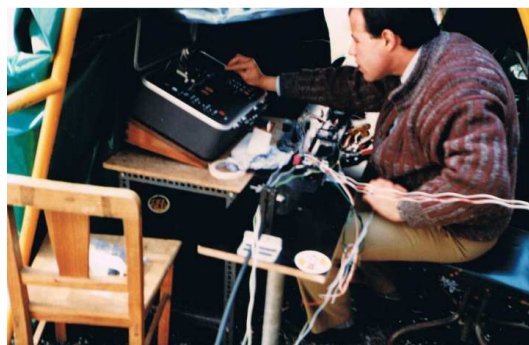
PTAP – Emenda por fusão da fibra ótica
