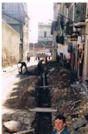
PTAP - Abertura de vala. Rua da Verónica
