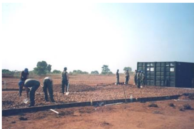
Construção da laje do refeitório geral e do bar da CTm5
